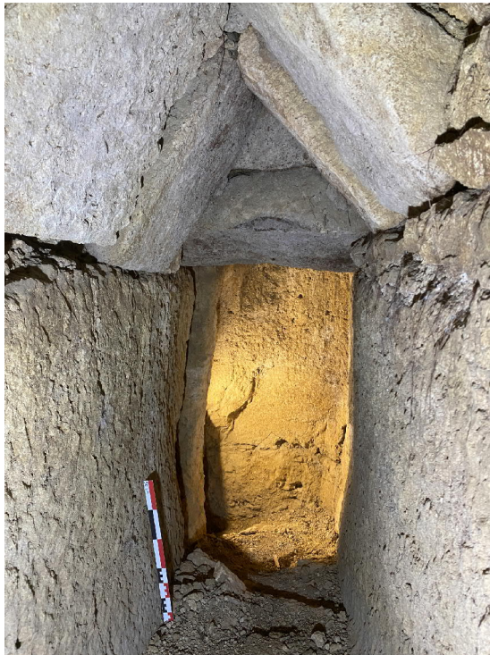
Fig. 10 : Souterrain de la Mathève (Lot-et-Garonne) : Galerie couverte de pierres en bâtière et posées à plat (Photo L. Stevens).
