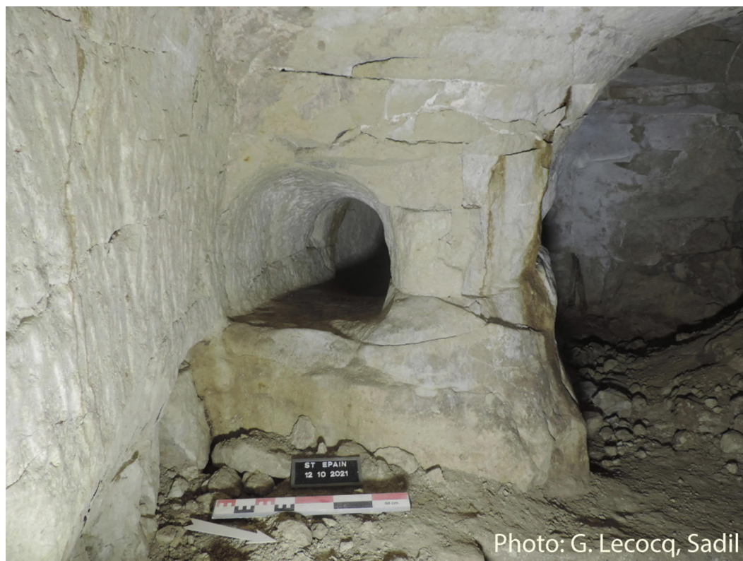
Fig. 6 : Saint-Épain : A gauche : Chatière en gueule de four. A droite : ouverture postérieure.
